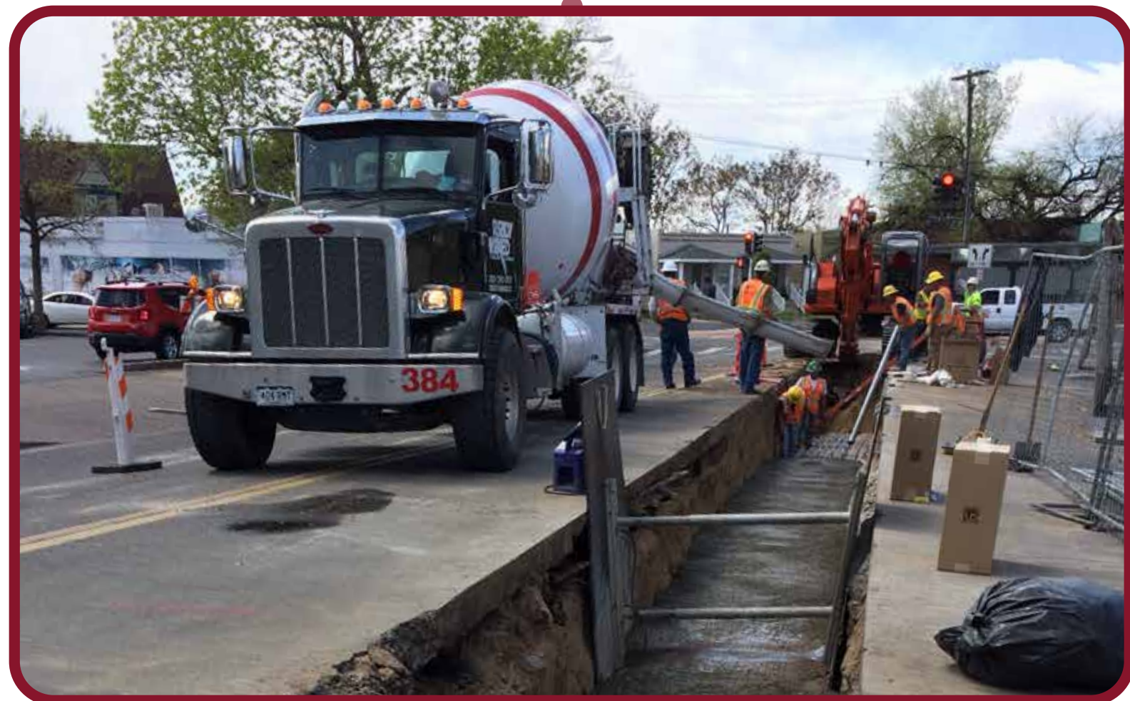
Pour concrete and slurry backfill
